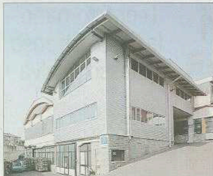
Rivestimento in pannelli d'acciaio e copertura a volta per il nuovo edificio
