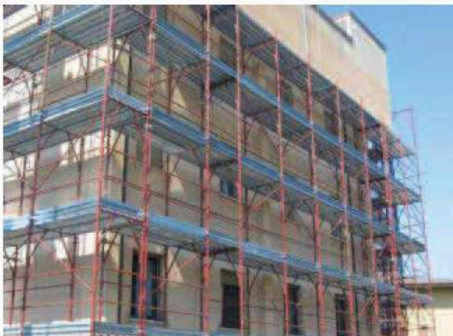
**Tipologia di intervento:** Riqualificazione statica ed energetica di un edificio residenziale con realizzazione di nuovi terrazzamenti in struttura metallica portante rivestita da parete in carpenteria leggera di acciaio zincomagnesio "magizink" e lastre di cemento fibrorinforzato Knauf "Aquapanel" alle quali viene incollato un cappotto termico di cm 5 di spessore, con caratteristiche di efficienza energetica spinte
