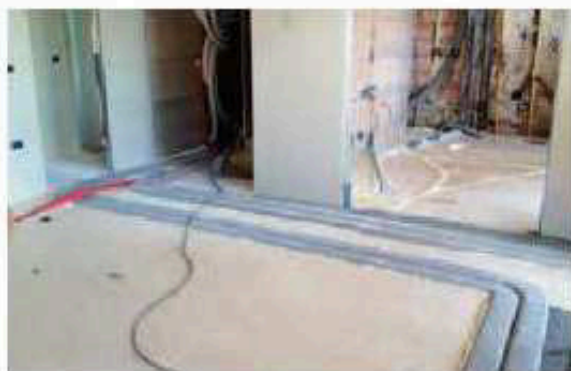
Isolamento del solaio contro terra e canali della ventilazione
