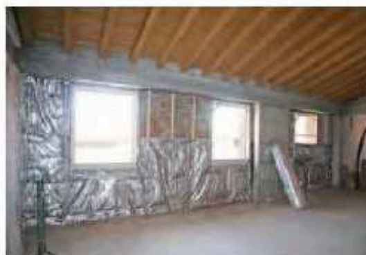
Isolamento termoriflettente nel lato interno della parete nord
