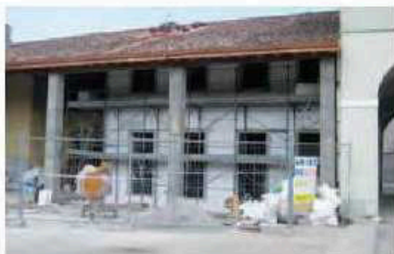
Posa del cappotto termoisolante lato sud
